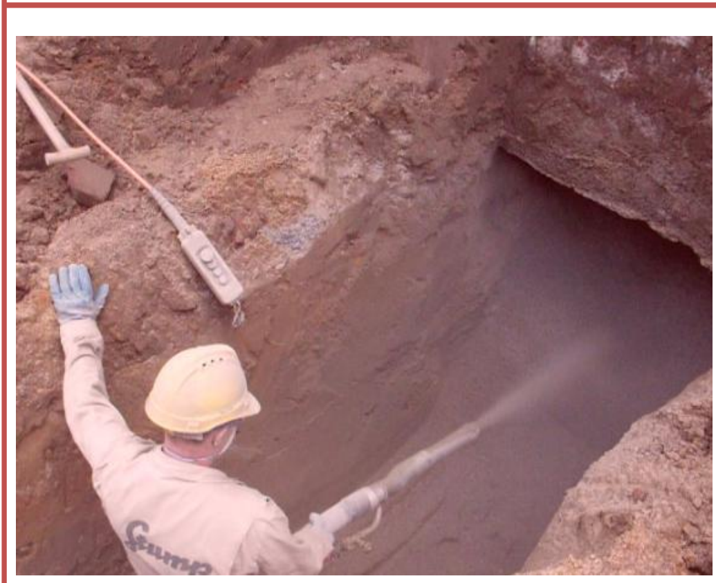
Staubfreies Arbeiten durch Nachmischen des Materials
